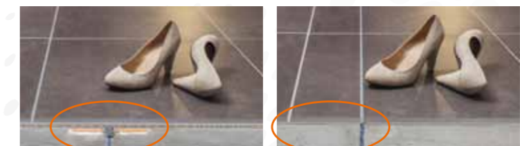
15 Na afvoegen met PCI Nanofug Premium de bewegingsvoeg die het dichtst bij de dilatatievoeg in de ondergrond ligt elastisch afkitten met PCI Silcoferm S. Deze siliconenvoeg kan even breed zijn als de andere voegen.
