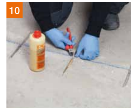
10 De plug PCI Apogel® Dübel in de gleuf leggen en de elastische ring doorknippen.
