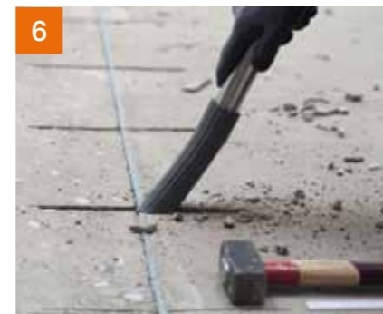
6 Losse delen met een industriestofzuiger verwijderen.
