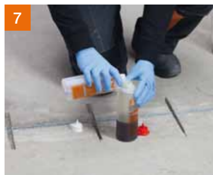
7 Na deze voorbereiding van de gleuven, de twee componenten van giethars PCI Apogel® SH samenvoegen...
