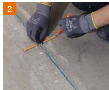
2 Na het reinigen van de dilatatievoeg de positie van de pluggen PCI Apogel® Dübel markeren...
