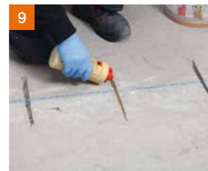
9 Een kleine hoeveelheid PCI Apogel® SH in de gleuf gieten.
