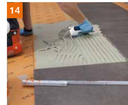
14 Ook de vloertegels holtevrij verlijmen met PCI Flexmörtel® S2.
