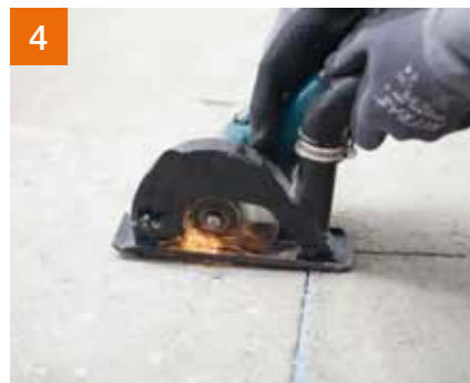
4 Daarna met een slijptol deze plekken inzagen...
