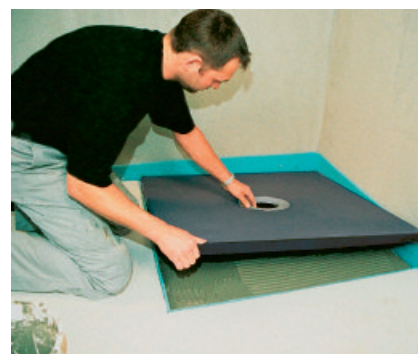
Met vloerelement PCI Pecibord kunnen drempelvrije douches in verschillende vormen en formaten snel worden ingebouwd.
