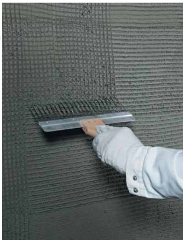
Opruwen van de waterdichtingspleister PCI Saniment® DP met een kam voordat saneerpleister wordt aangebracht
