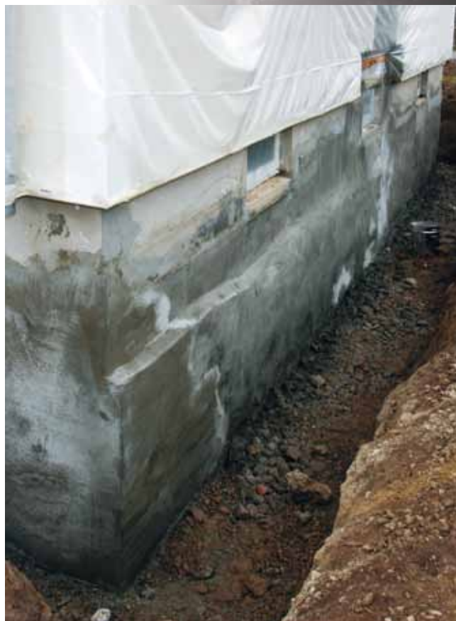
Vrijgelegde en uitgevlakte kelderbuitenmuur voor het aanbrengen van de afdichting
