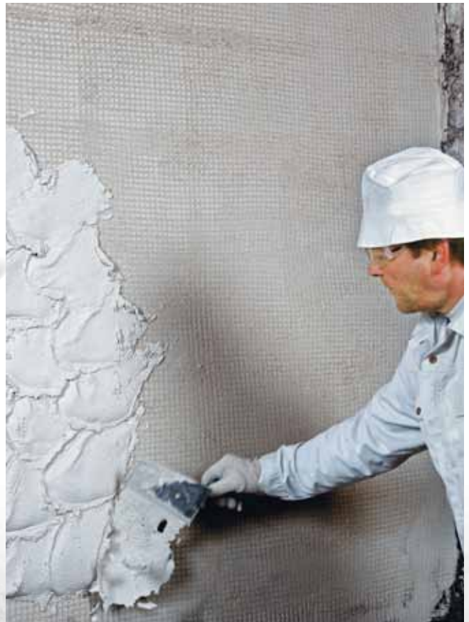
Verwerking van de tweede laag PCI Saniment® Classic: Voor het aanbrengen van de tweede laag moet de eerste opgeruwd worden.
