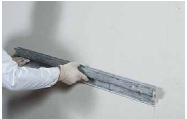
Verwerking van de sulfaatbestendige saneerpleister PCI Saniment Super in één laag
