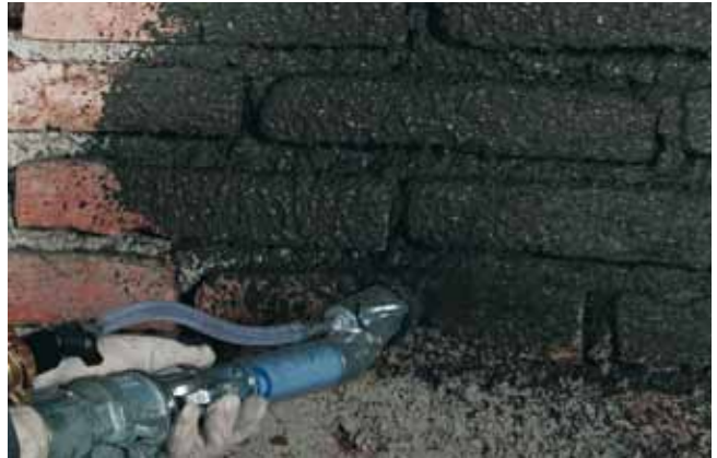
Ondergrondvoorbereiding voordat wordt uitgevlakt met spatlaag PCI Saniment HA
