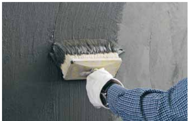
Afdichting tegen indringend vocht met waterdichtingsmortel PCI Saniment DS
