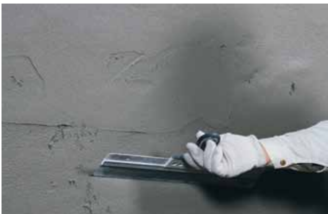
Uitvlakken van oneffenheden met waterdichtingspleister PCI Saniment DP
