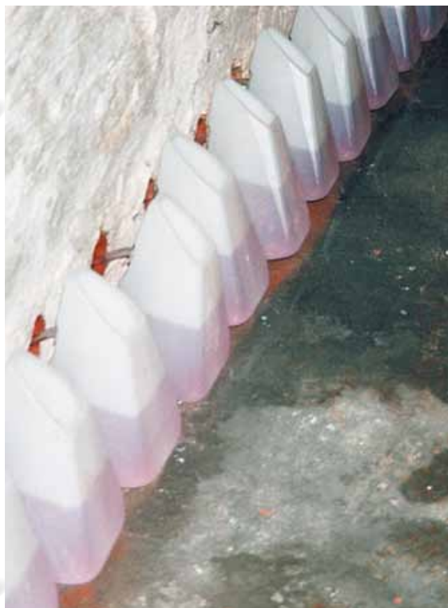
Aanbrengen van horizontale afdichting door injectie zonder druk met PCI Bohrlochsperrre en PCI Injektionsbehälter
