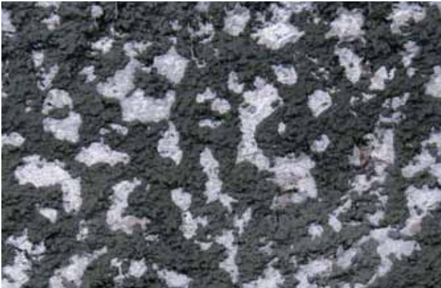
Ondergrondvoorbereiding met spatlaag PCI Saniment HA
