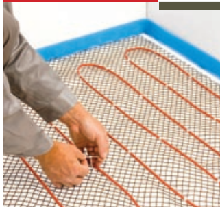
Plaatsing van de kabel
