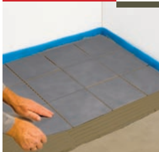
Plaatsen van de tegels
