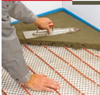
Plaatsing van dekvloer
