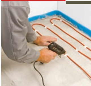
Plaatsing van de kabel
