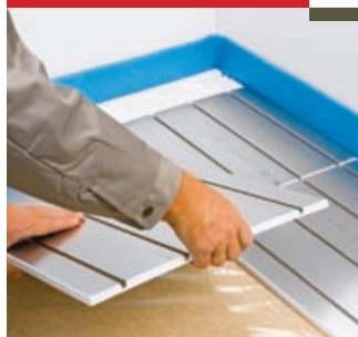
Installatie van de platen
