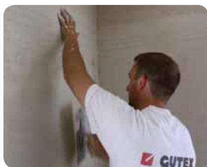
GUTEX universeel wapeningsnet over de volle oppervlakte aanbrengen
