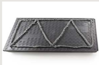
1 Aanbrengen lijm op isolatiepaneel
