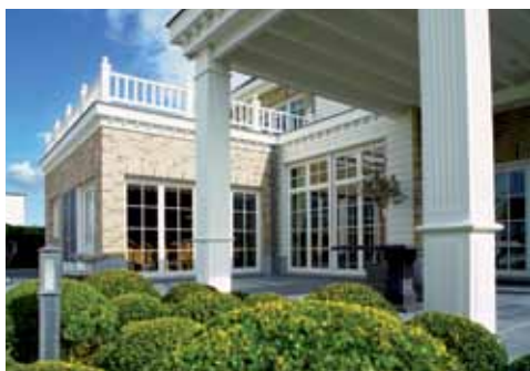
64 Corum - Architect: Sylvain Maurissen, Bilzen (BE)
