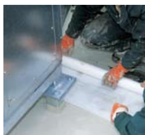
doordat de vloeibare hars als een tweede huid iedere vorm afdicht.
