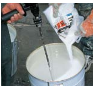
Katalysator aan de basishars toevoegen en grondig oproeren.
