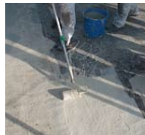
Het nat in nat aanbrengen van een tweede laag Triflex ProDetail.
