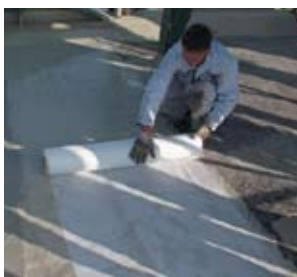
Ook moeilijk bereikbare plaatsen worden gegarandeerd afgedicht.
