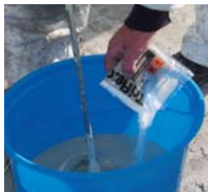
Katalysator aan de basishars toevoegen en grondig oproeren.
