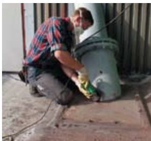
Vorbereiding van de ondergrond.
