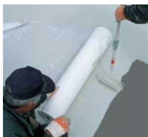
Op het oppervlak de eerste laag Triflex Protect aanbrengen.
