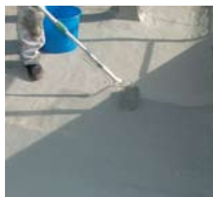
doordat de vloeibare hars als een tweede huid iedere vorm afdicht.
