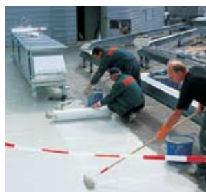
Het Triflex Speciaalvlies volledig blaasvrij aanbrengen.
