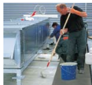
Het nat in nat aanbrengen van een tweede laag Triflex Protect.
