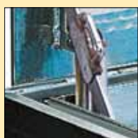
Luik vergrendelt automatisch in de verticale openingsstand.
