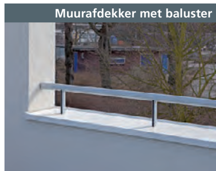
Muurafdeksysteem t.b.v. hellend dak
