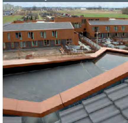
Muurafdeksysteem t.b.v. hellend dak
