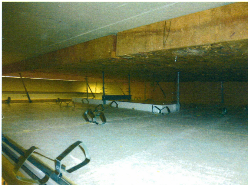
Bild 2 Gesamtansicht: Deckenunterkonstruktion „Rockfon + CMC Deckenverkleidung“
