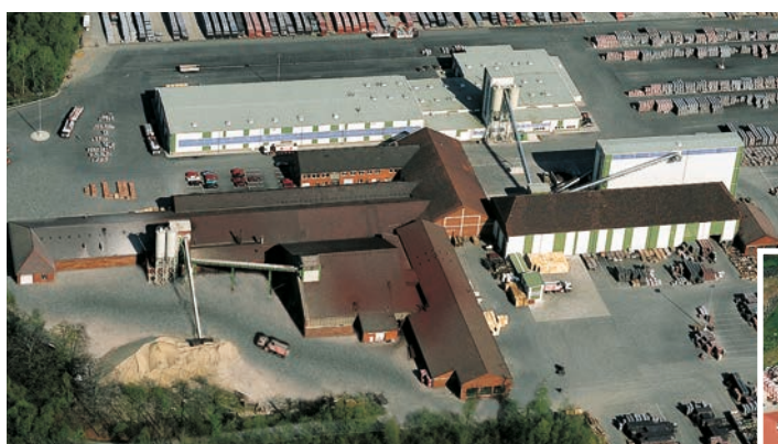
Fabriek Schermbeck-Gartrop (betonpannen)
