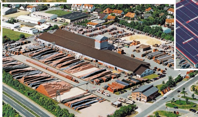
Fabriek Dieburg (betonpannen)
