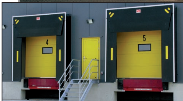
Dock deur voorzien van rechthoekig dubbel plexiglas raam
