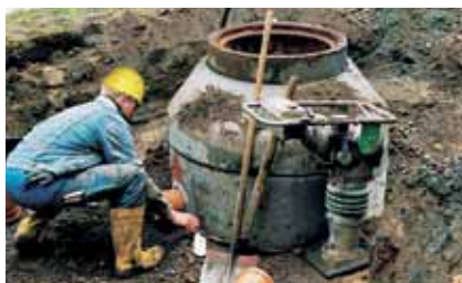
Eenvoudige montage van de aan- en afvoersleidingen aan de afscheider.
