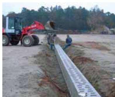
ACO Drain® RoadDrain RD300 op een vliegveld
