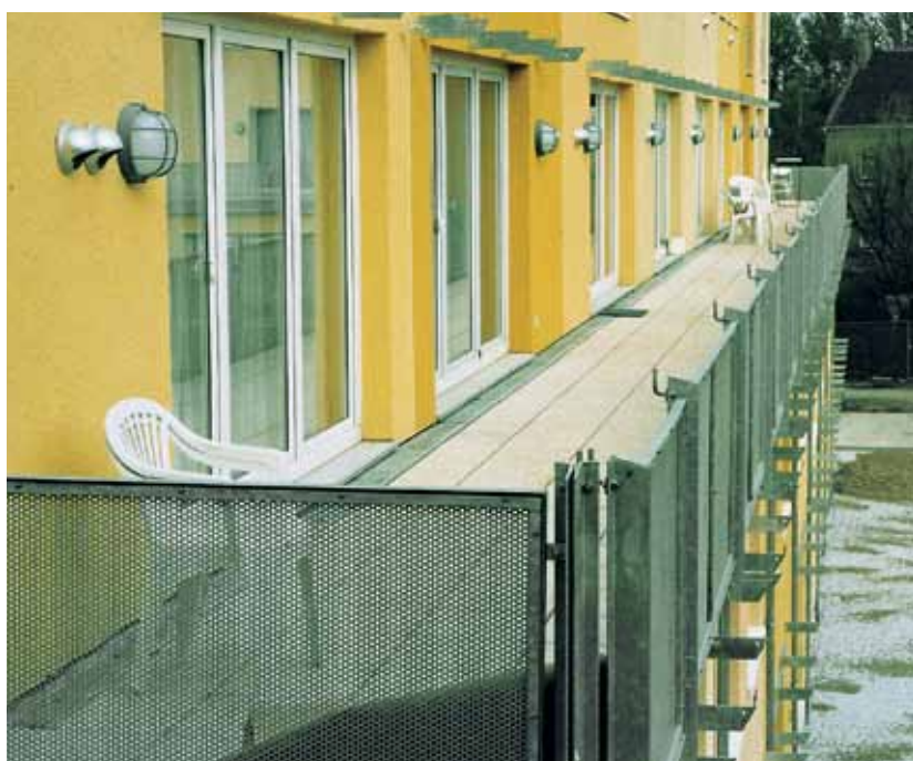
Galerijafwatering met ACO ProfiLine , hoogte drempel < 5 cm
