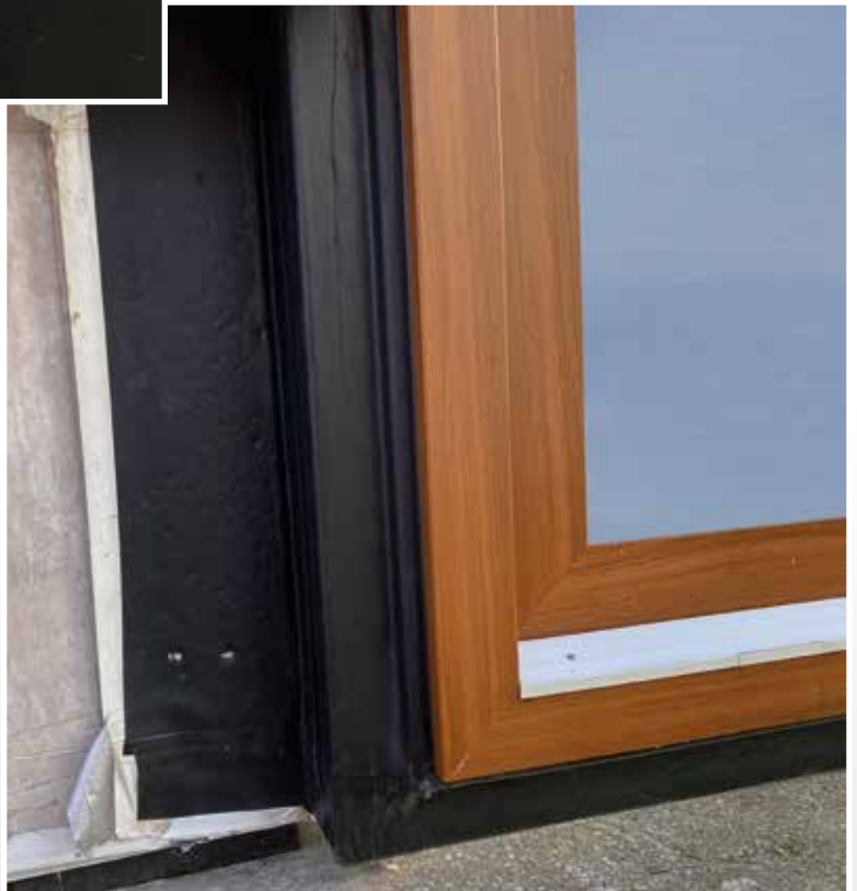
EPDM kader met gelaste hoek
