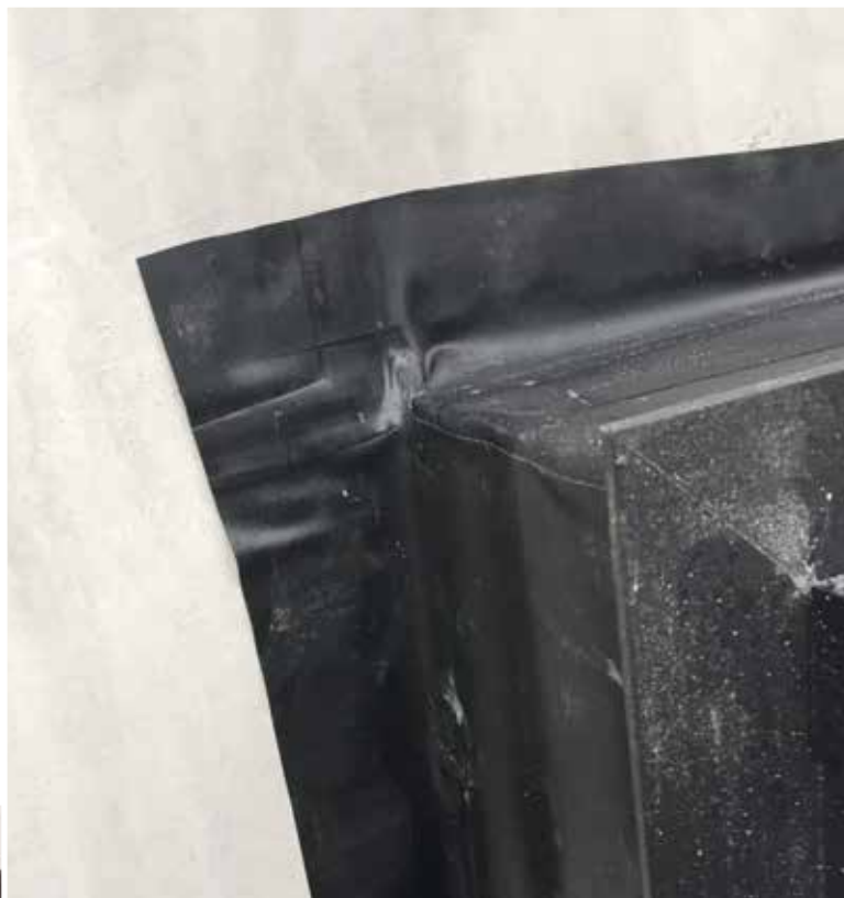
EPDM kader met gelaste hoek
