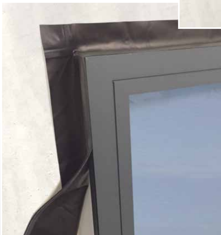
U-vorm met EPDM inklikprofiel
