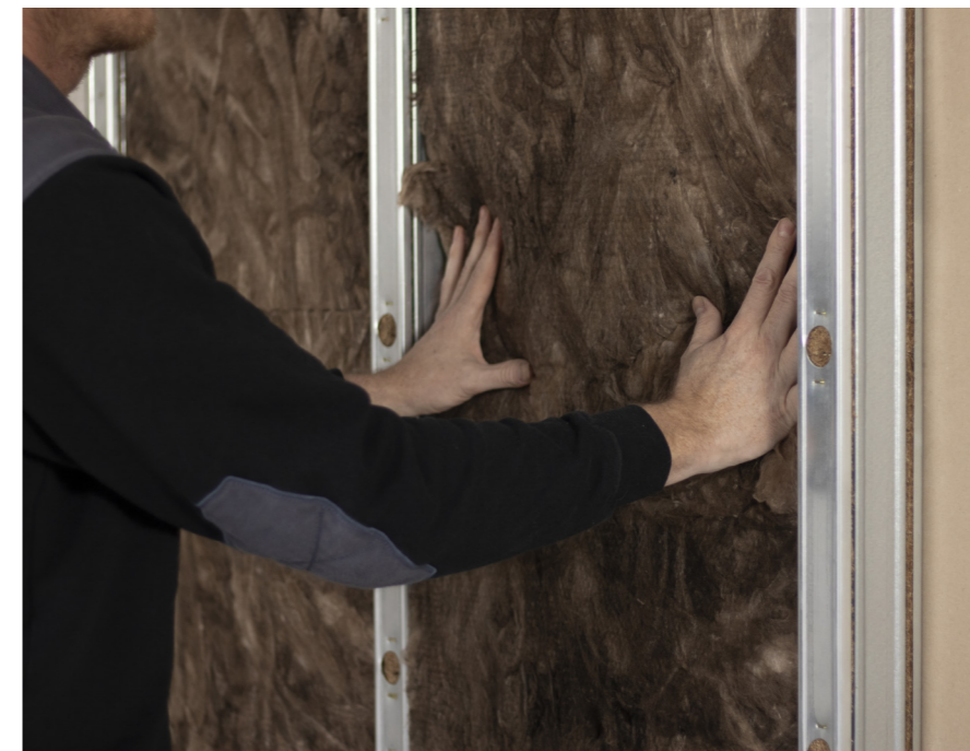
Aanbrengen van Knauf Acoustifit tussen de staanders.
