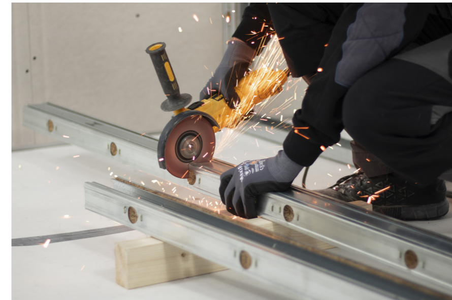
Op maat maken van de Knauf MaxSpace profielen.
