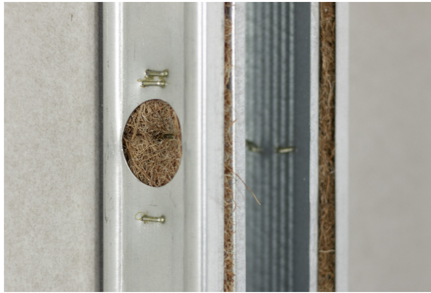
De wand wordt aan beide zijden bekleed met 12,5 mm Knauf A-plaat en 12,5 mm Knauf Diamond Board. De spouwruijme wordt voorzien van 60 mm glaswol Knauf Acoustifit. De totale wanddikte bedraagt 125 mm.
