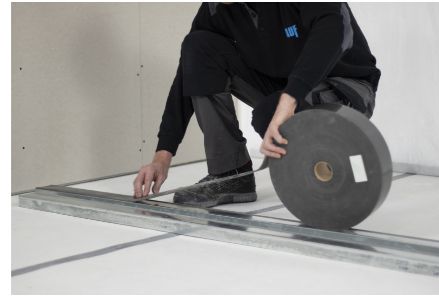
Voorzie alle op de omringende bouwdele aansluitende profielen van Knauf Dichtingsband.
