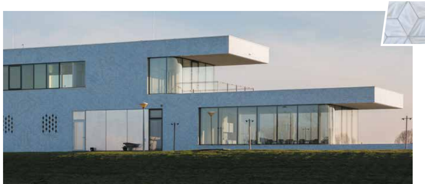
Bedieningscentrale Amerongen Afwerking Keramische tegelafwerking
